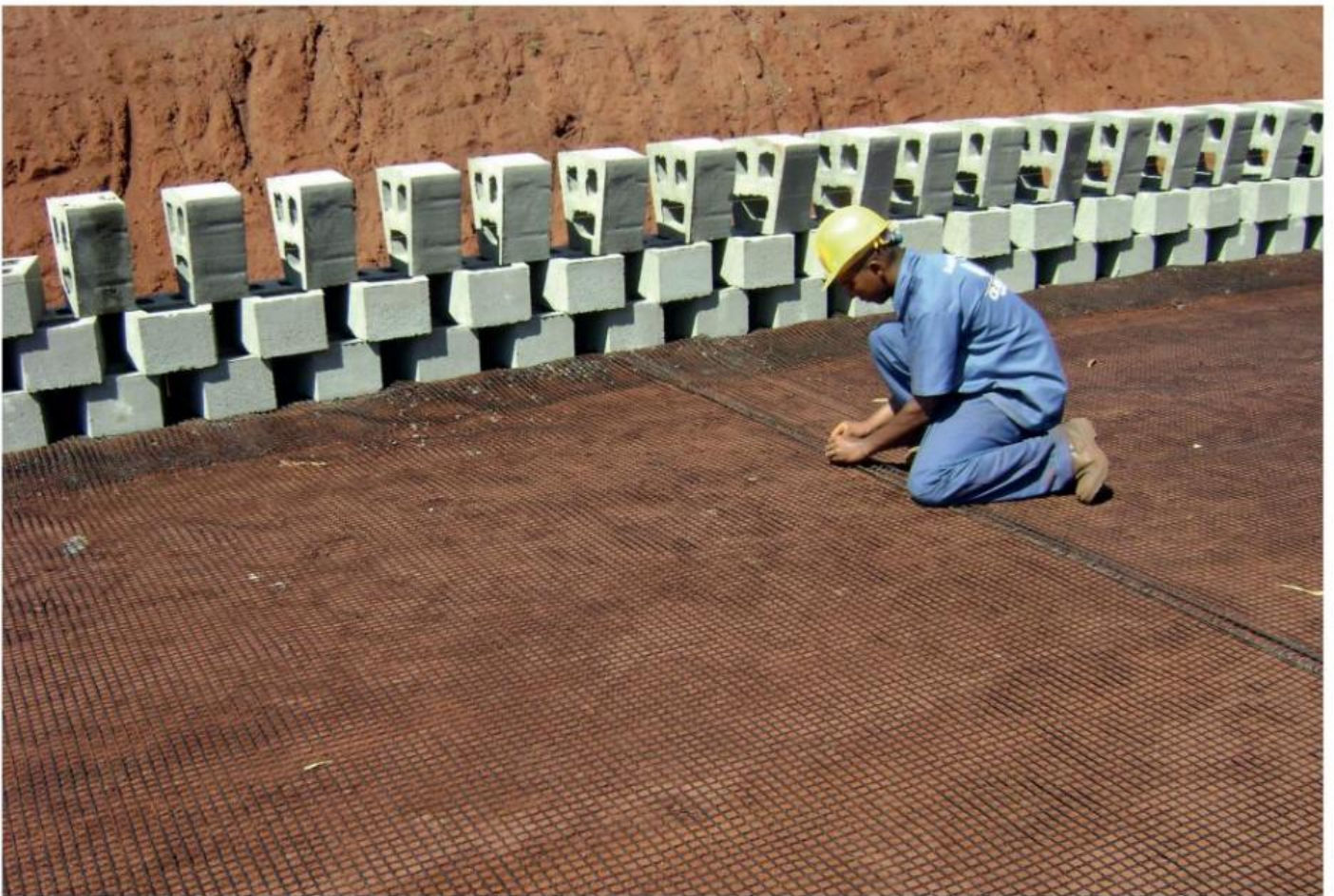
Muro Terrae executado em Maringá (PR)
