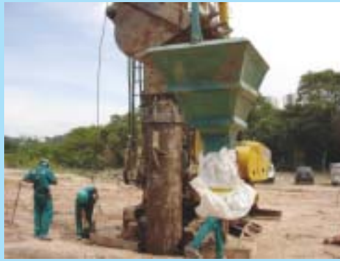
Obra em São José dos Campos (julho 2006)
