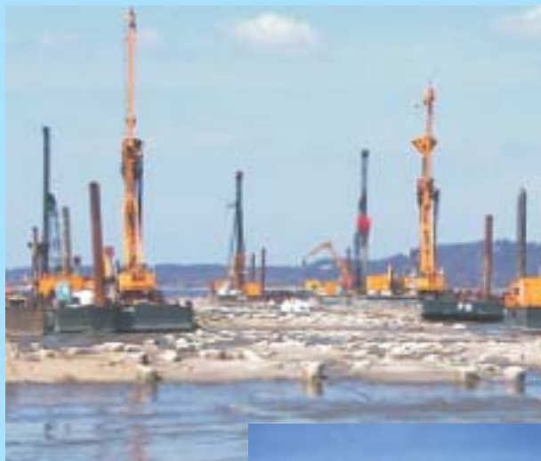
Obra típica em Colunas Ringtrac e detalhe de uma coluna
