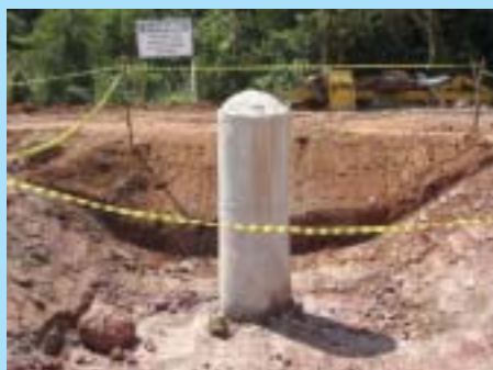
Coluna recém executada
