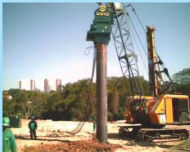
Trabalho em execução, São José dos Campos (SP)
