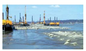
Bild 1. GEC-Herstellung in extrem weichem Schlick von Pontons (Quelle: Josef Möbius Bau-GmbH) Fig. 1. GEC production from pontoons in very soft/fluid mud (Source: Josef Möbius Bau-GmbH)
