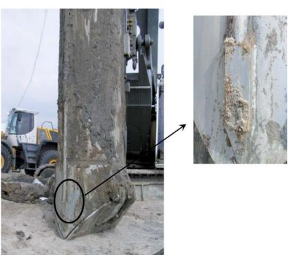
Bild 12. Verdrängungsrohr mit Messtechnik für Erfassung akustischer Signale (Quelle: Josef Möbius Bau-GmbH) Fig. 12. Displacement pipe with instrumentation for measuring acoustic signals (Source: Josef Möbius Bau-GmbH)
