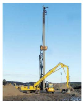
Bild 10. LRB 255 mit 30 m langem Verdrängungsrohr auf einer Baustelle in Polen (Quelle: Josef Möbius Bau-GmbH) Fig. 10. Pile driver LRB 255 with 30 m-long displacement pipe at a site in Poland (Source: Josef Möbius Bau-GmbH)
