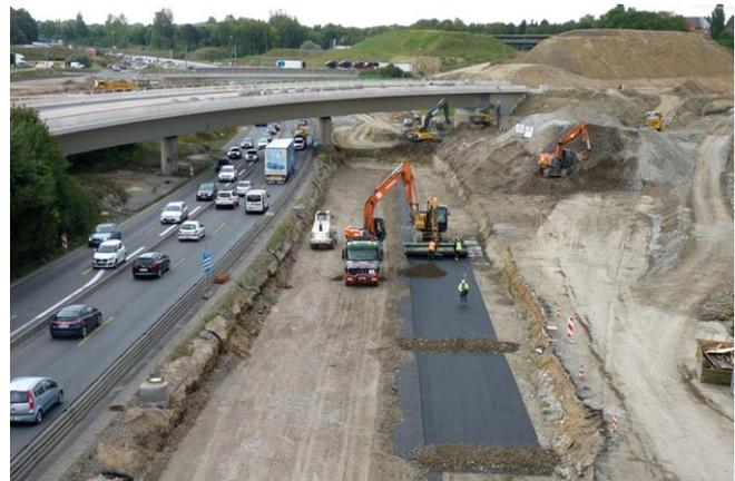
Abb.4 : Vorrichtung und Technik zur strammen Verlegung von Geobewehrungen, korrekt verlegtes Geogitter (von links nach rechts)
