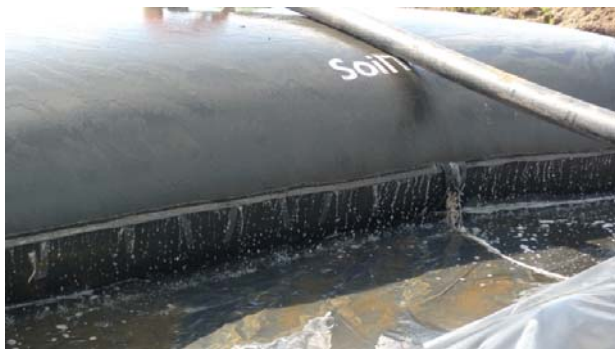
Abbildung 5.1-2 Entwässerung [HUESKER]
