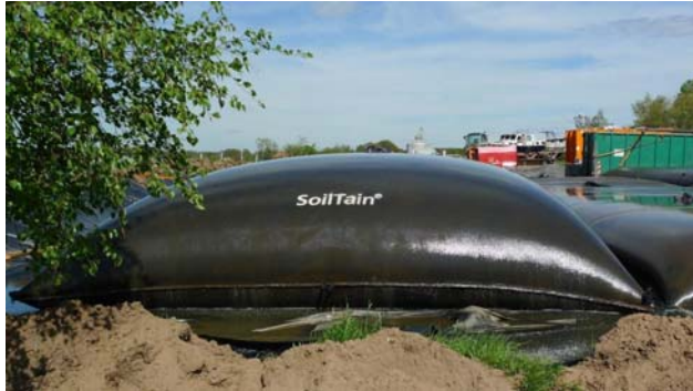
Abbildung 5.1-1 Befüllter Entwässerungsschlauch [HUESKER]
