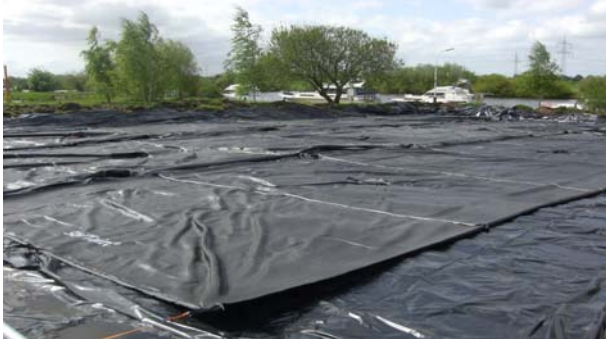
Abbildung 3.3-1 Zur Befüllung vorbereitete Entwässerungsschläuche auf dem Entwässerungsfeld [HUESKER]
