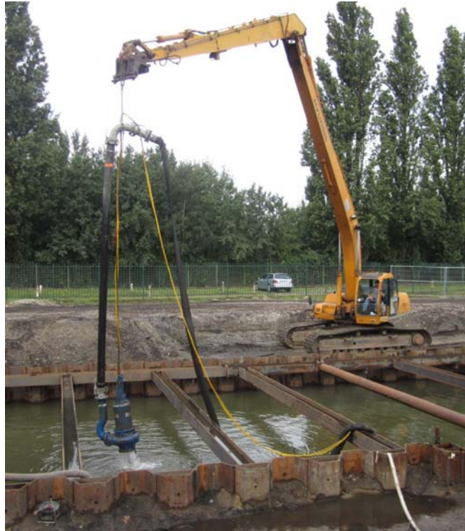
Abb. 3.4 Ansicht der Baugrube mit Förderequipment
