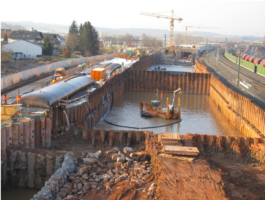
Abb. 3.1 Ansicht der Baugrube mit Saugbagger (Watermaster) und Entwässerungsschläuchen
