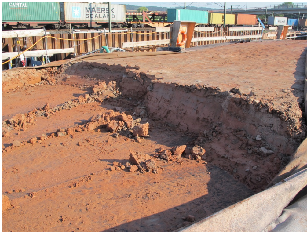
Abb. 3.3 Abtransport des entwässerten Materials
