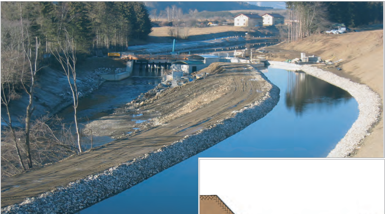
Der naturnah gestaltete Oberwasserkanal „Wasserkraftwerk Ritzersdorf“ nach Fertigstellung
