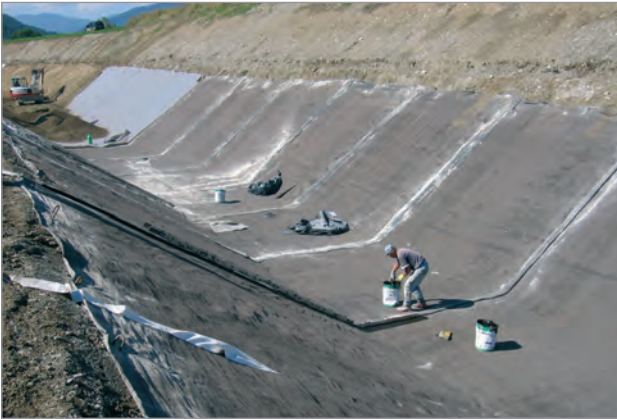
Nach der Verlegung der NaBento® RL-C werden die Überlappungsbereiche mittels Spezialkleber dicht und schubfest verbunden
