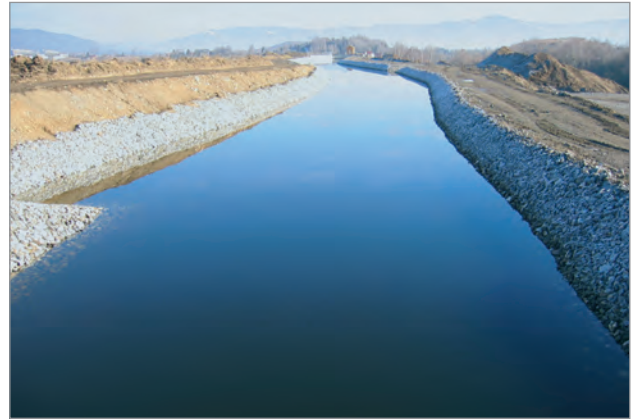
Der Oberwasserkanal fügt sich optisch gut in die Landschaft ein
