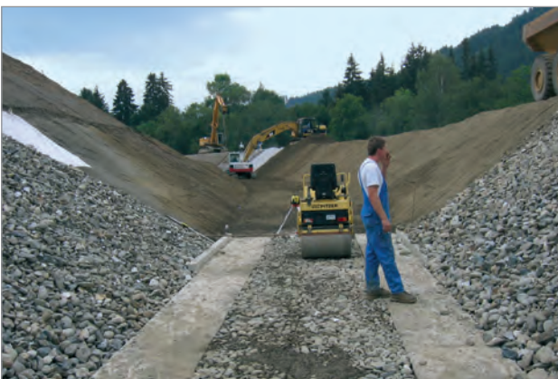
Die hergestellte Kanalabdichtung ist setzungsunempfindlich und kostengünstig
