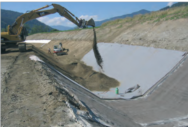
Aufbringen von Schüttung und Grobschlag
