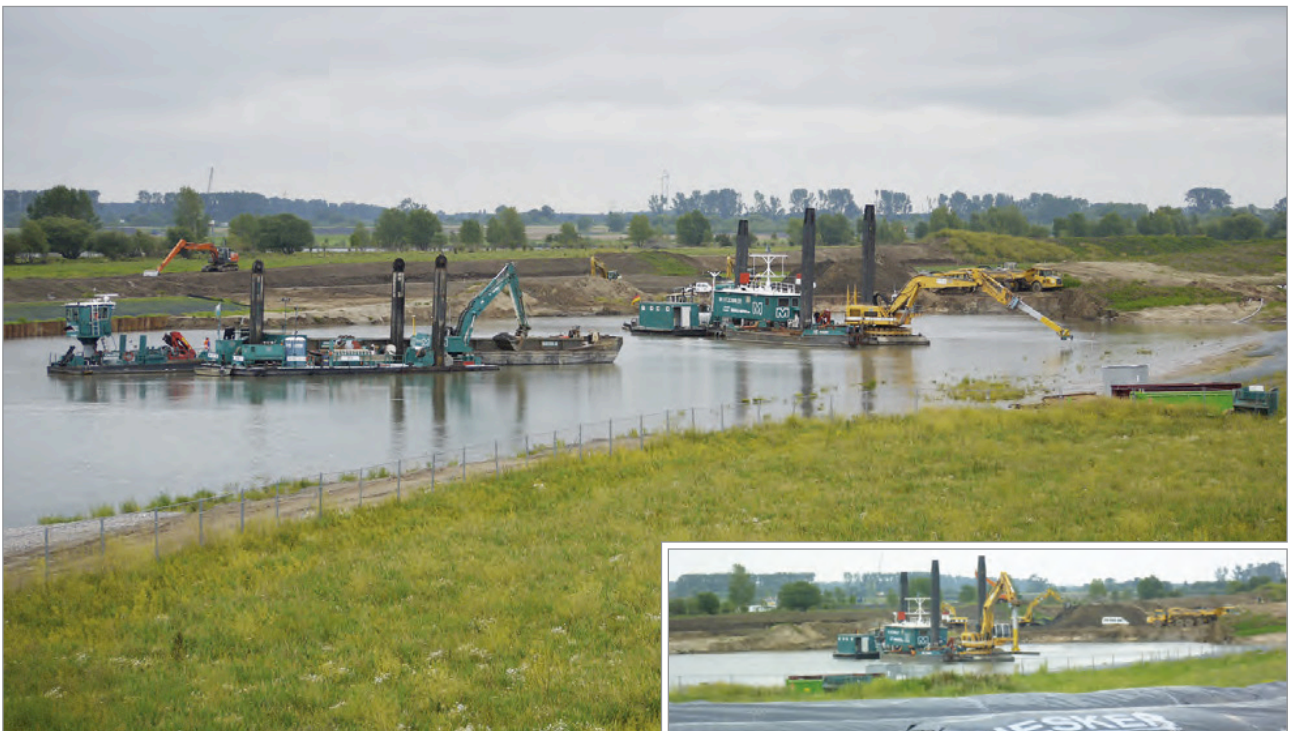
Teilabschnitt des Bauvorhabens: links: Einbau Wasserbausteine rechts: Baggerponton zur Verlegung der Sandmatte
