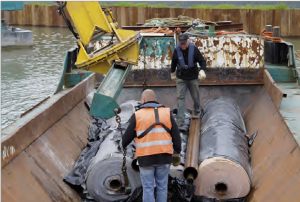
Bestückung der Verlegetraverse
