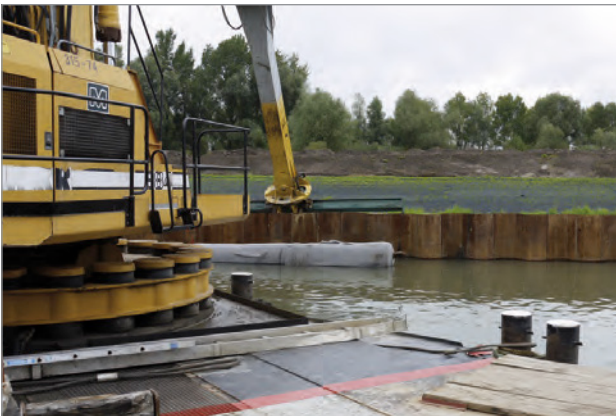
Verlegung der Sandmatte unter Wasser
