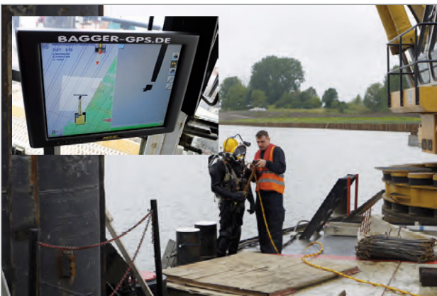
Kontrolle der Verlegung via GPS und Taucher
