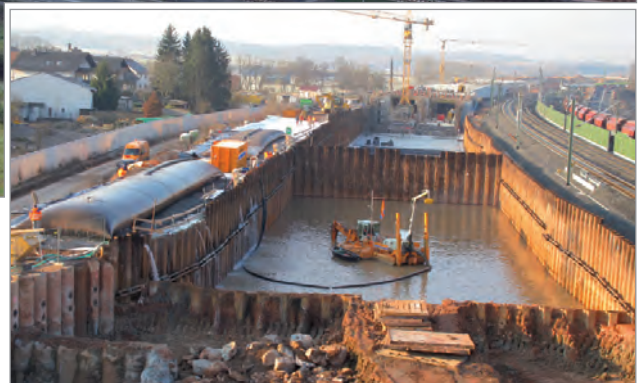
Ansicht der Baugrube
