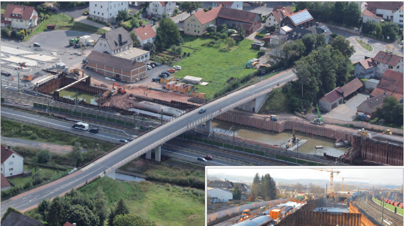
Luftbild der Baustelle, mit freundlicher Genehmigung der Bickhardt Bau AG
