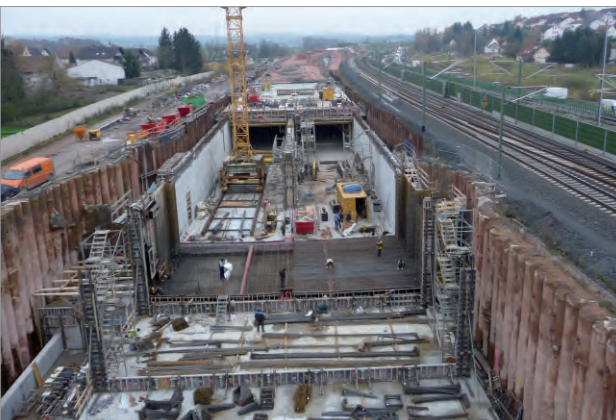
Baufortschritt des Tunnels nach Einsatz der SoilTain®-Entwässerungsschläuche
