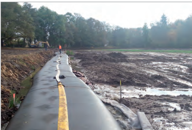
Schläuche (hier während der Befüllung) als Verlauf der neuen Uferlinie
