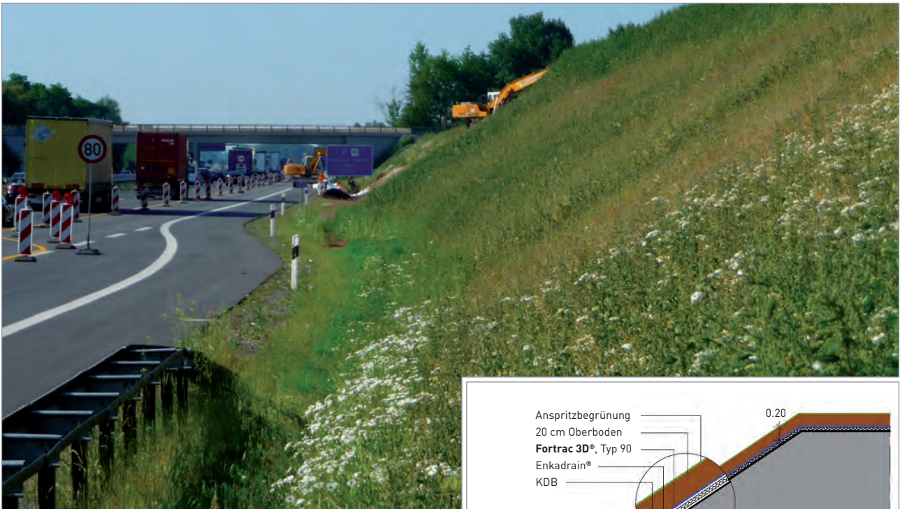
Blick über den Lärmschutzwall in Richtung Süden
