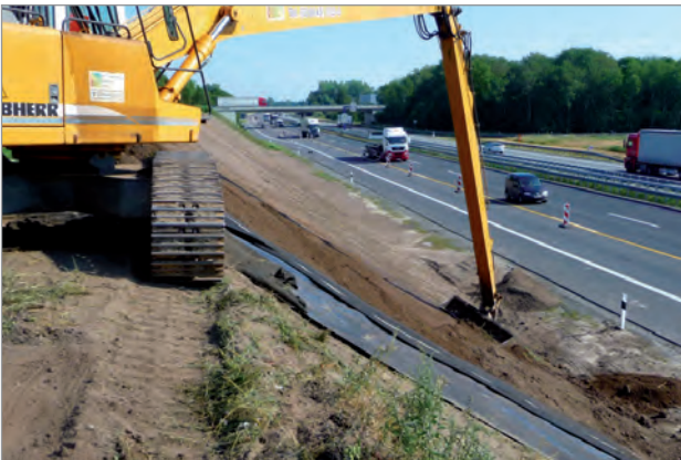
Profilierung des Oberbodens von der Böschungskrone aus
