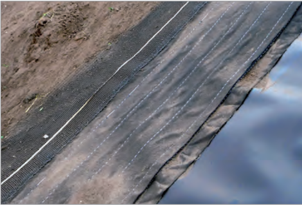
Abdichtungskomponenten KDB, Dränmatte, Antigleitbewehrung
