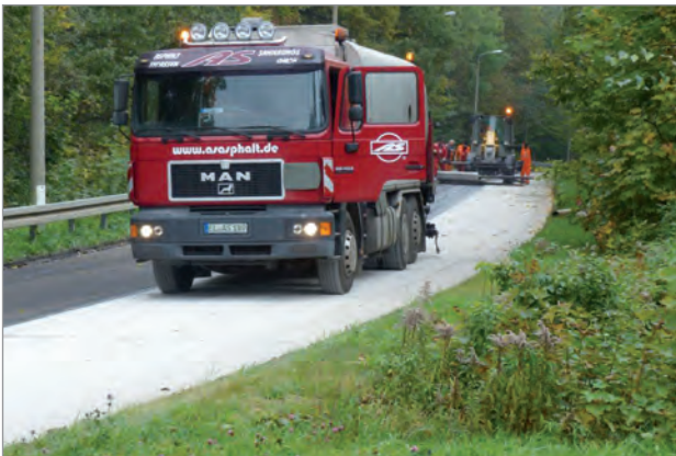
Aufbringen der Bitumenemulsion
