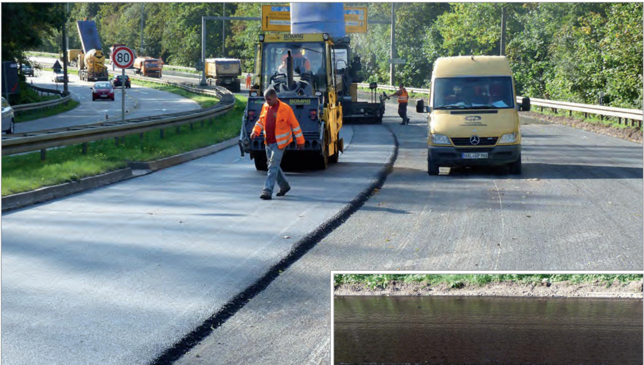
Asphalteinbau auf SamiGrid® XP 50 S
