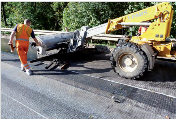
Verlegen von SamiGrid® in die Bitumenemulsion
