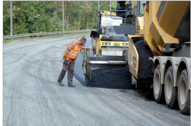
Einbau der Asphaltbinderschicht
