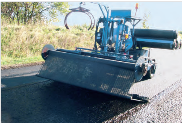
HaTelit ® kann sofort auf die gefräste Oberfläche aufgebracht werden
