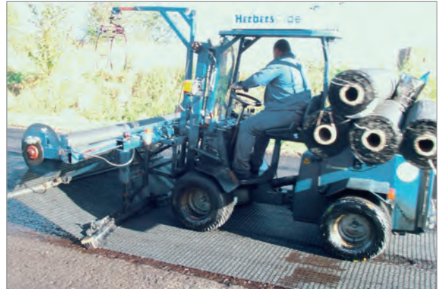
Die HaTelit ®-Verlegung erfolgt einfach und schnell
