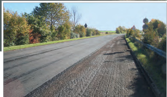
Die L 264 rechts gefräst – links bereits mit HaTelit® aufgebaut
