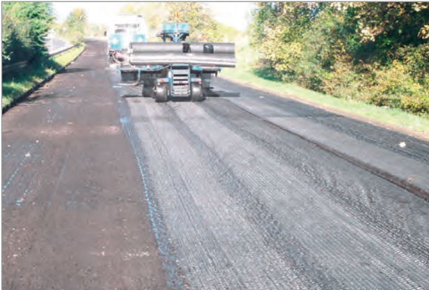
Die L 264 wurde abgefräst und anschließend ...
