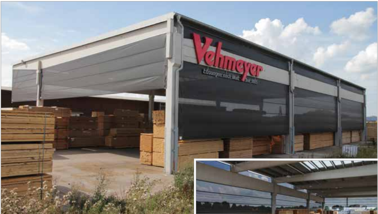
Holzlager der Fa. Vehmeyer in Haselünne
