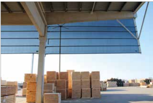
Windlastenaufnahme durch waagerechte Verspannung
