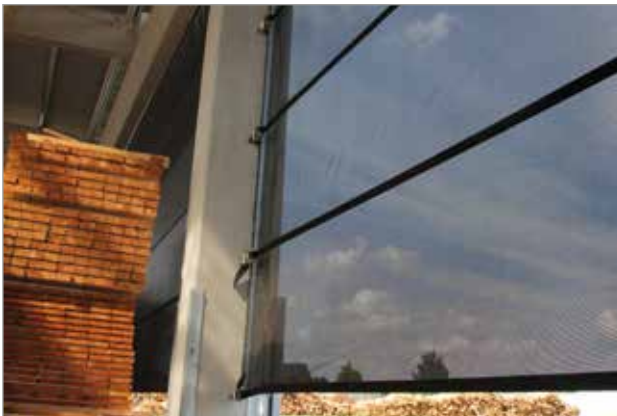
Befestigung mit Ratschen-Spanngurt-Einheiten
