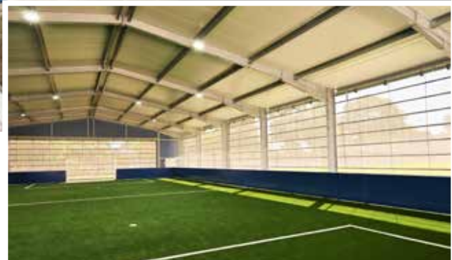
Tectura Gewebe sorgen für eine gute Belüftung und viel Tageslicht
