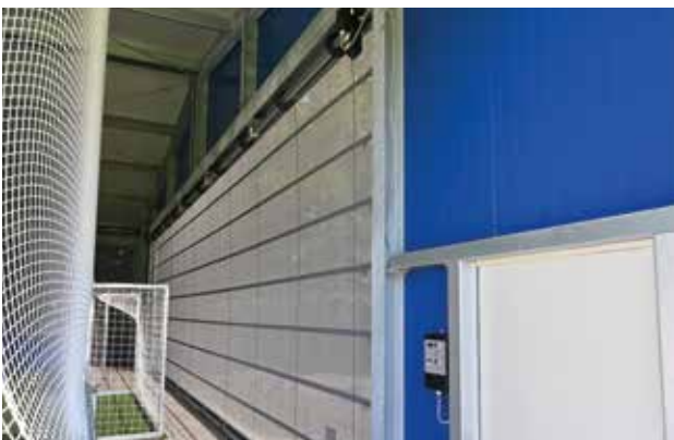
Durch die Verlegung der Antriebseinheit nach innen, ist eine ansprechende Optik von außen und Schutz vor Witterungseinflüssen gegeben.
