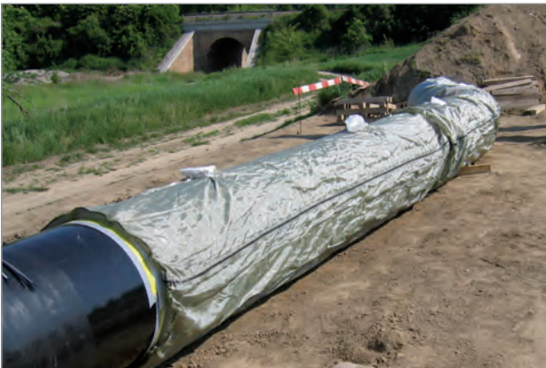
Ein Incomat ® -„Mantel“ vor der Befüllung
