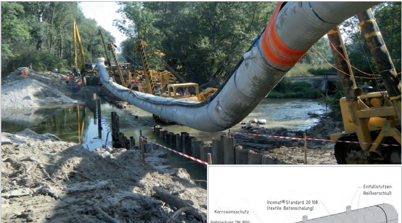
Einheben des Dükers Nr. 12 im Bereich „Hechtengraben“
