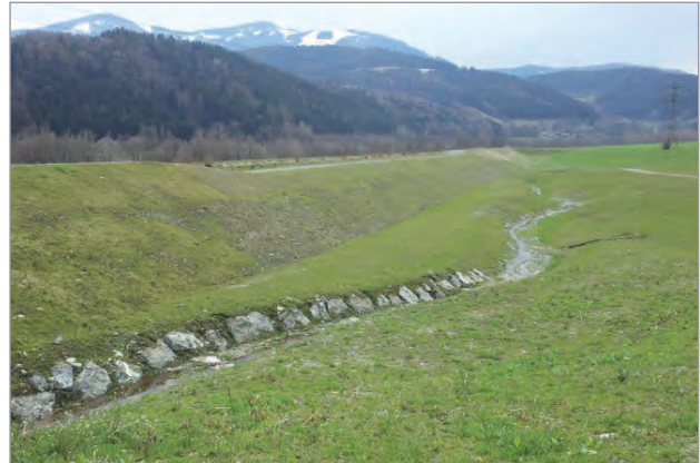
Überströmstrecke nach Abschluss der Arbeiten
