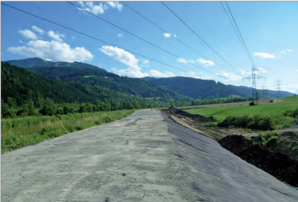
Profilierte Dammkrone und vorbereitetes Planum
