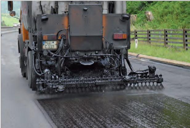
Ansprühen der Bitumenemulsion
