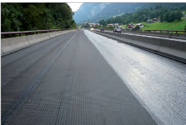
Im linken Bereich fertig verlegte Asphaltbewehrung
