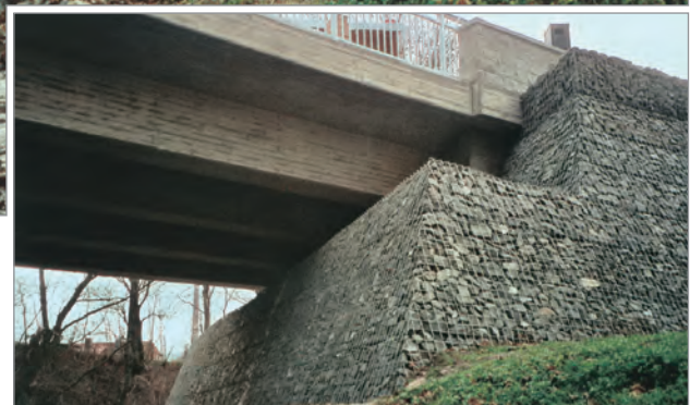
Der Lastenabtrag erfolgt über den KBE-Körper, auf den die Widerlagerbank direkt aufbetoniert ist.
