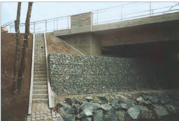
Die Front wird aus Schotter-/Wasserbausteinen gefüllten Gabionen gebildet.
