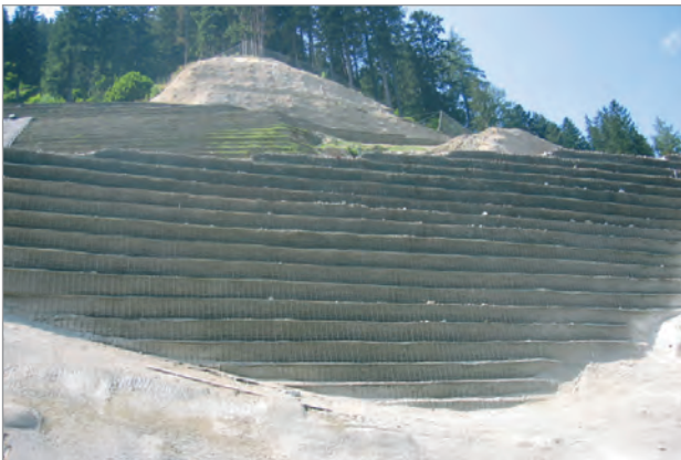
Trotz einfachster Bauweise sind mit KBE-Konstruktionen anspruchsvollste Geometrien im unwegsamen Gelände realisierbar
