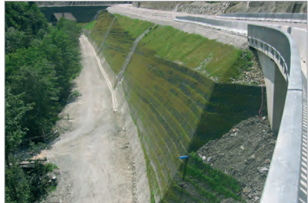
Streckenabschnitt mit Brückenwiderlager kurz vor Verkehrsfreigabe
