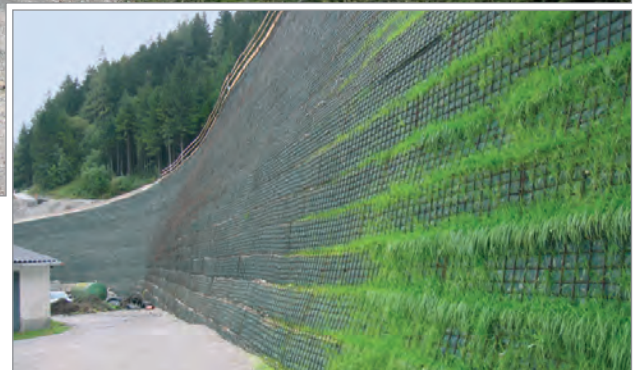
Auskeimen der Vegetation zum Schutz der Geokunststoffbewehrungen vor UV-Strahlung
