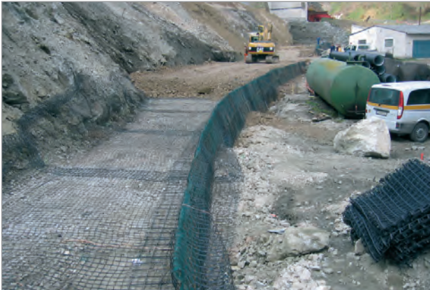
Bauzustand: verlorene Stahlschalungen als Frontabschluss, flächige Verlegung der flexiblen Geogitter
