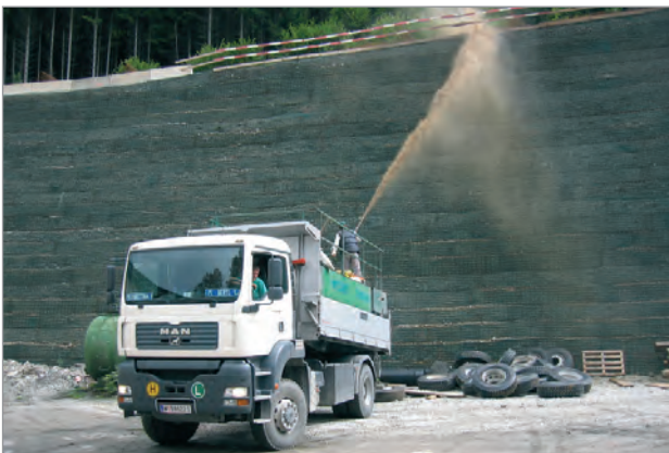
Aufbringen der Anspritzbegrünung (Erstbegrünung)
