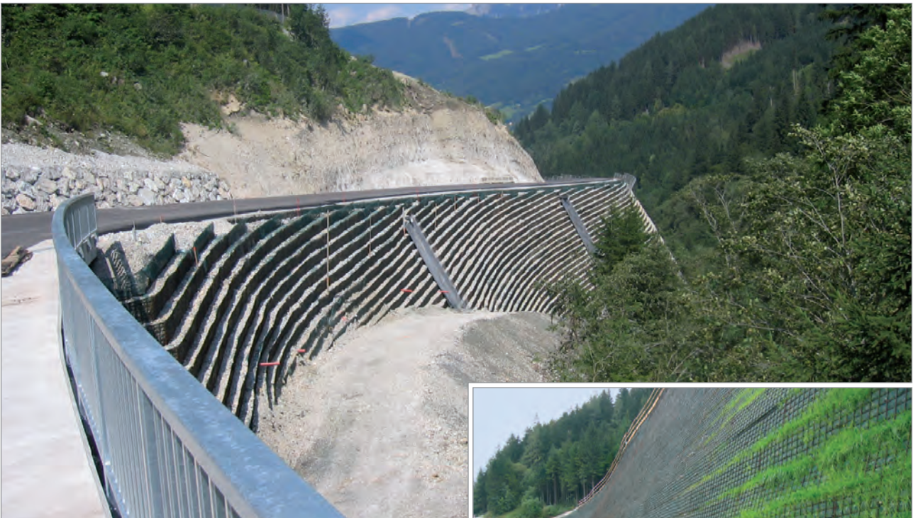
Neubau der Bundesstraße 114 als KBE - Konstruktion
