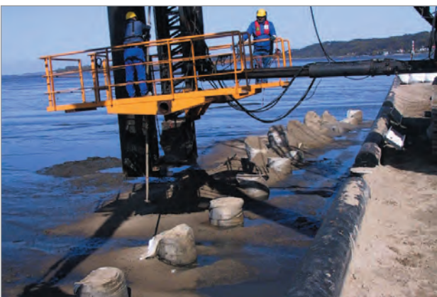
GEC Einbau vom Ponton
