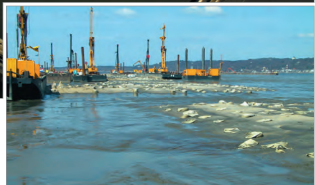
Einbau der GEC's
