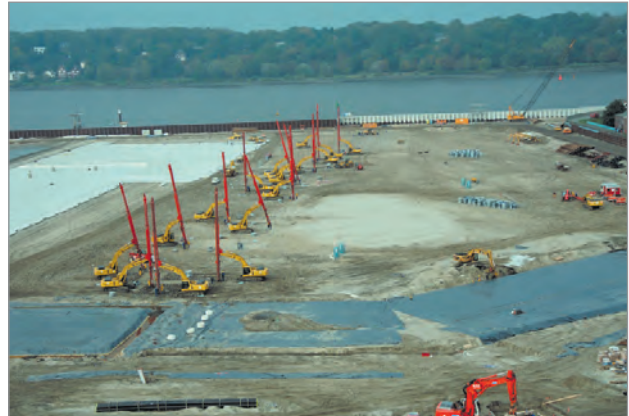
Einbau der Vertikaldrainagen
