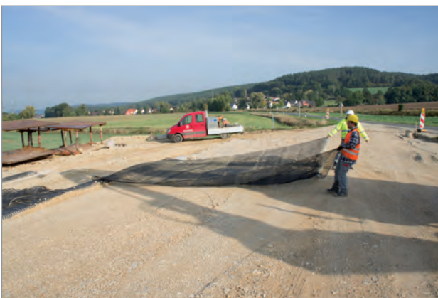
Ausführung des Rückumschlags der Fortrac® Geogitter
