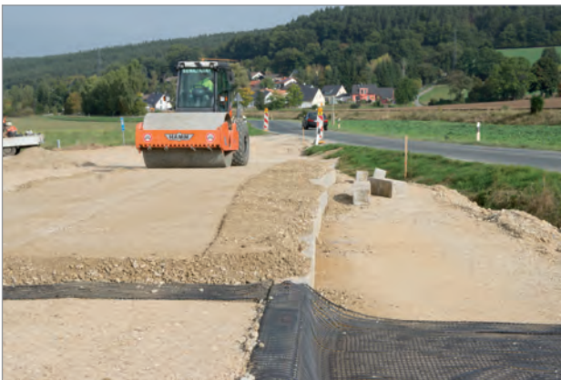
Verlegen der Fortrac® Geogitter über den Fertigbetonpfählen
