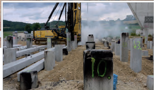
Rammung der Fertigbetonpfähle bis auf tragfähigen Buntsandstein
