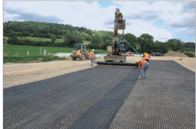
Verdichtung des Schüttmaterials
