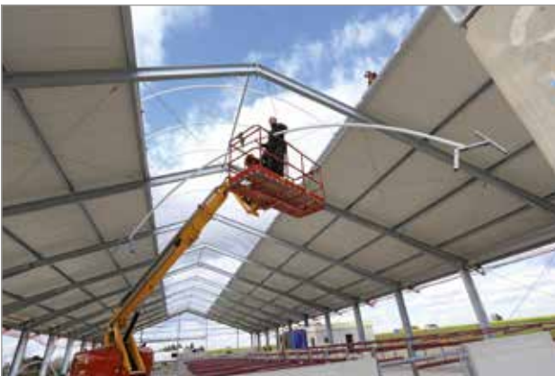
Montage der Bügel an der Dachkonstruktion
