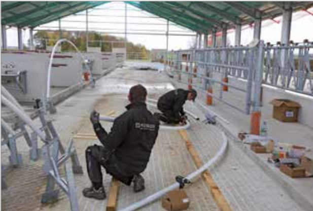
Vormontage der Bügel am Boden
