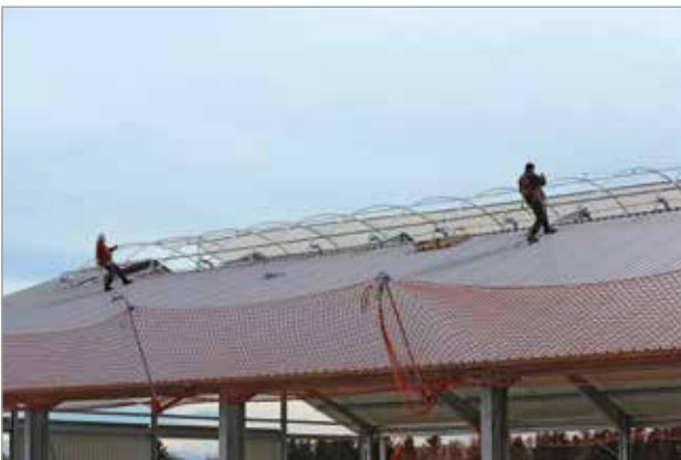
Plane über die Konstruktion ziehen
