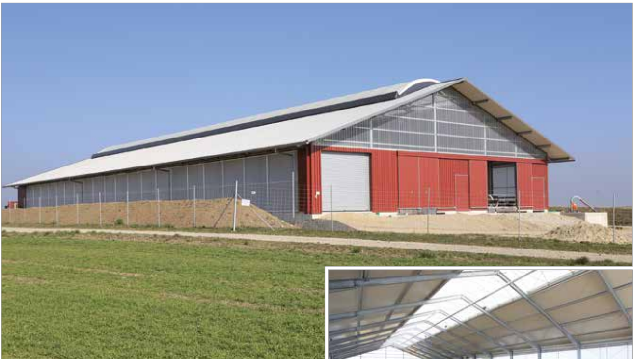
Moderner Boxenlaufstall in Oberbayern mit Seitenlüftung und Lichtfirst
