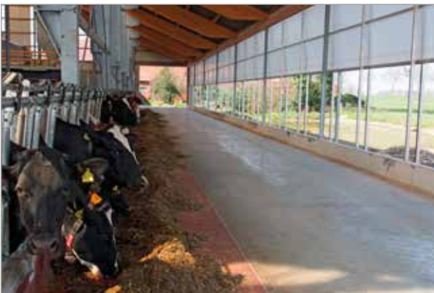
Innenansicht Lubratec Wickellüftung-XL „unten öffnend – mittig wickelnd“
