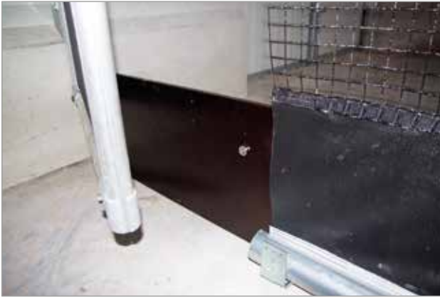
Detail: Türverschluß mit Magneteinbau an der Filmplatte; Fixierung der Rollwand und der Filmplatte im Balkenschuh
