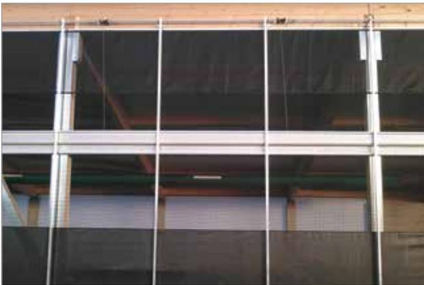
Lubratec Kalb-Wickellüftung im geöffneten Zustand
