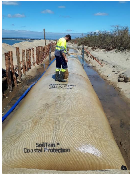
Bild 3 (HUESKER_SoilTain Tube filling in Ayamonte):
