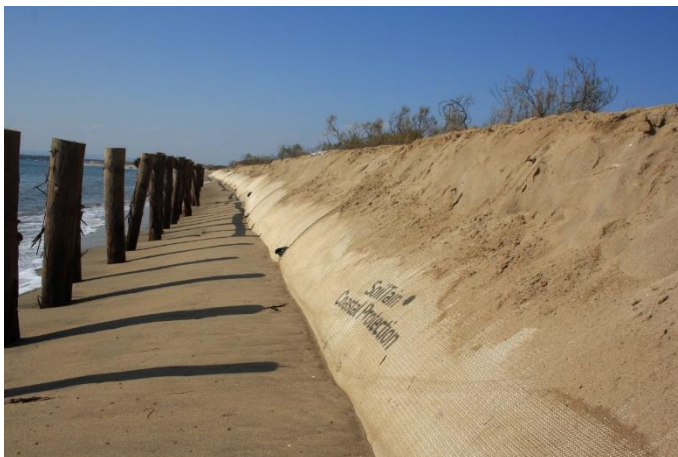
Bild 2 (HUESKER_Project Ayamonte Spain):
