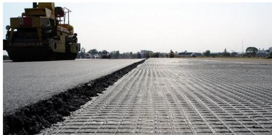
Bild 3 *HUESKER Asphalt Reinforcement\_HaTelit:*
