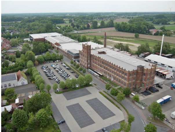
Bild 1 HUESKER Gescher Stammsitz Luftaufnahme
