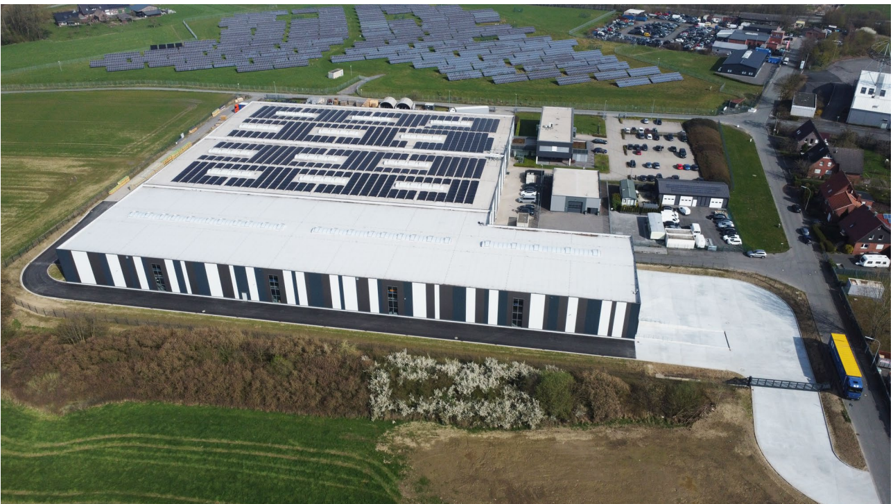
Luftbild des erweiterten Produktionsstandortes „Im Brömken“, Credit: © GOLDBECK
