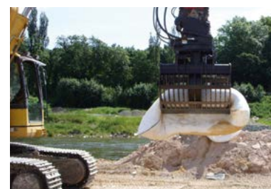
Einbau mit Hilfe eines Baggers o. Ä.
