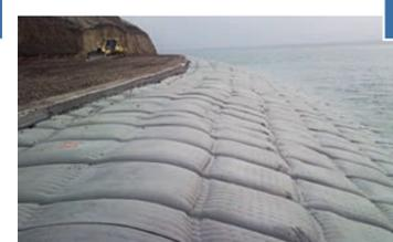
Befüllung der Panels mit fließfähigem Beton/Mörtel
