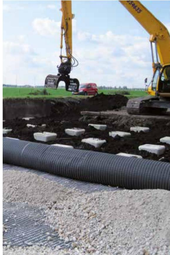
Verlegung der Geokunststoffbewehrung auf vertikalen Traggliedern
