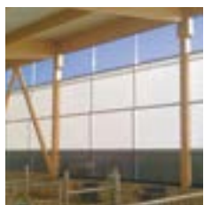
Lubratec Wickellüftung Kälber
