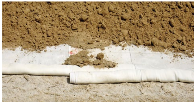
Überlappende / überschüttete Bahnen
