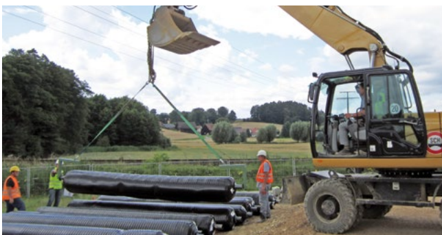
Verwendung der Hebe-/Verlegehilfe
