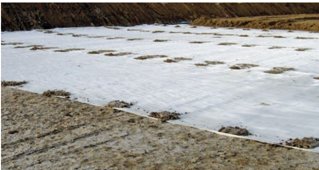
Ballastierte / überlappende Bahnen
