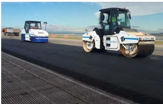
Beim Zurücksetzen vor den Fertiger müssen starke Lenkbewegungen sowie heftiges Beschleunigen und Abbremsen der Transportfahrzeuge vermieden werden.
