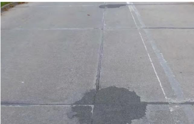
Einzelrisse mit weniger als 3 mm Rissbreite können unbehandelt bleiben. Dehnungsfugen und Risse mit einer Breite größer als 3 mm sind nach der Reinigung mit einer bitumenhaltigen Masse zu vergießen.
