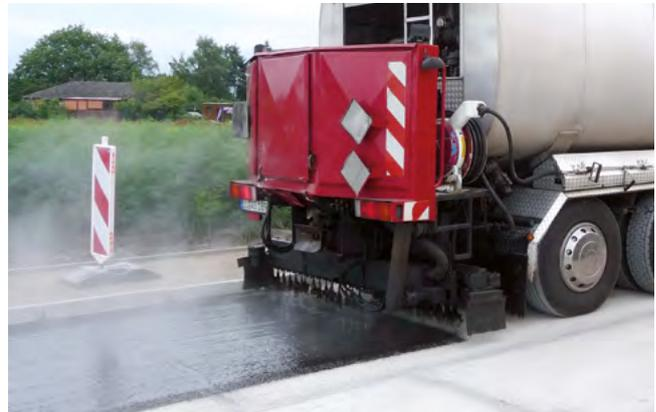
entsprechend erhöht werden. Bei gefrästen Unterlagen kann eine Menge von  $2,3 \text{ kg/m}^2$  erforderlich sein.
