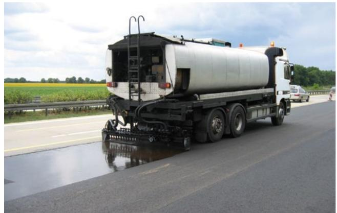
Das Ansprühen hat mittels eines Rampenspritzgeräts so zu erfolgen, dass eine gleichmäßige Verteilung der Bindemittelmenge erreicht wird und somit ein vollflöchiger Kontakt zu HaTelit gewährleistet ist. In engen Radien bzw. Einmündungen kann das Ansprühen mit einer Handlanze erfolgen.
