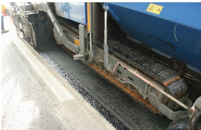
Fertiger und Transportfahrzeuge sind vorsichtig zu fahren, um die Schubbeanspruchung der Gitterbahn so gering wie möglich zu halten.
