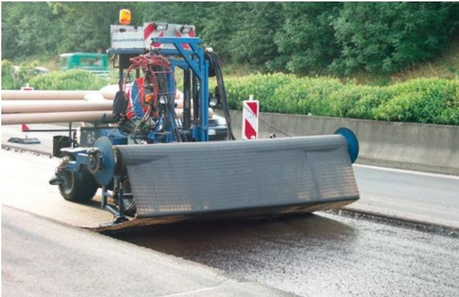
Nach, beziehungsweise während des Verlegens muss HaTelit in die Emulsion gedrückt werden, zum Beispiel mit einem Straßenbesen, um eine gute Tränkung herzustellen. Gegebenfalls kann HaTelit nach der Verlegung mit einer leichten Tandemwalze zusätzlich angedrückt werden.
