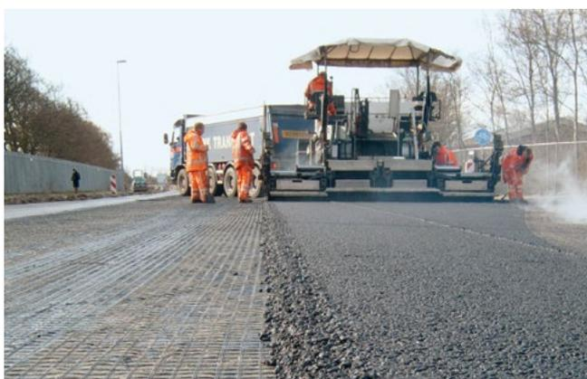
Beim Zurücksetzen vor dem Fertiger müssen starke Lenkbewegungen sowie heftiges Beschleunigen und Abbremsen der Transportfahrzeuge vermieden werden.
