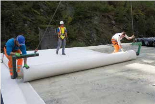
Einbau der selbstheilenden Sekundärabdichtung Typ Tektoseal Clay 5000+
