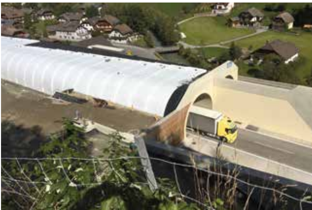
Einbau Drän- und Schutzmatte als dritte Lage Geokunststoff
