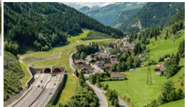
Einhausung nach Fertigstellung der Baumaßnahme
