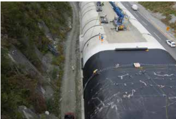
Einbau der Primärabdichtung aus PE-HD 2,0 mm verschweißt und auf Dichtheit geprüft.
