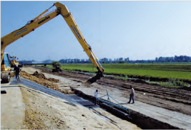
Verlegung von NaBento® RL-N+ via Verlegetraverse
