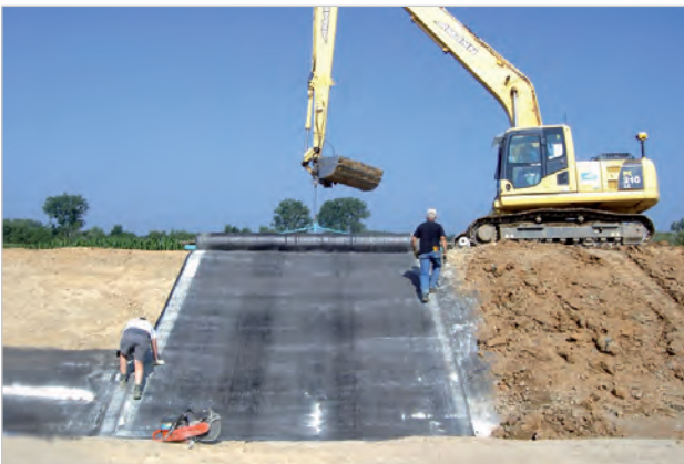
Einbau der GTD
