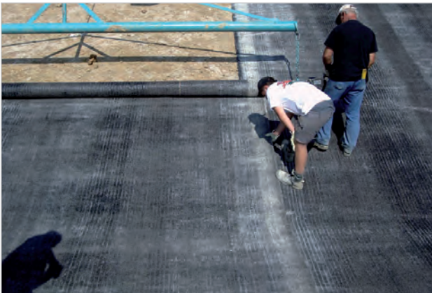
Überlappung zweier GTD Bahnen
