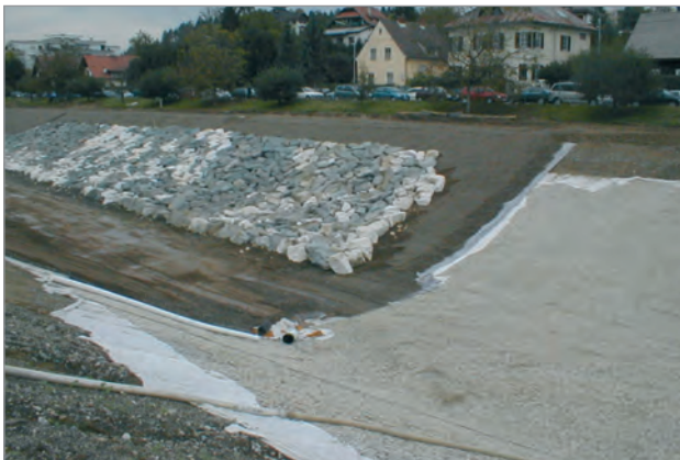
Schichtaufbau der neuen Böschung
