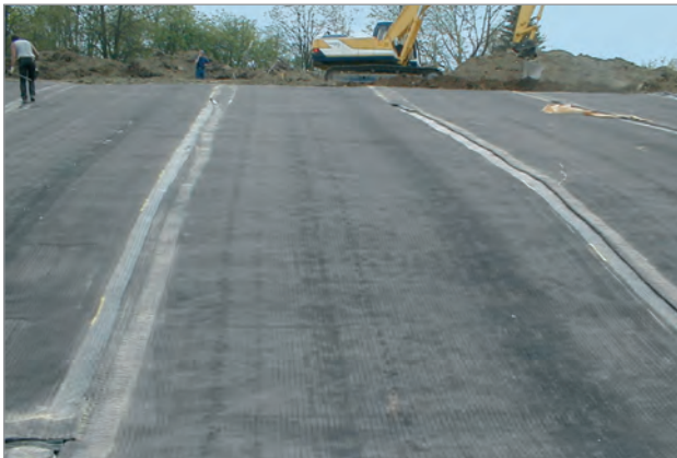
Fixierung der Überlappung der GTD mittels Spezialkleber
