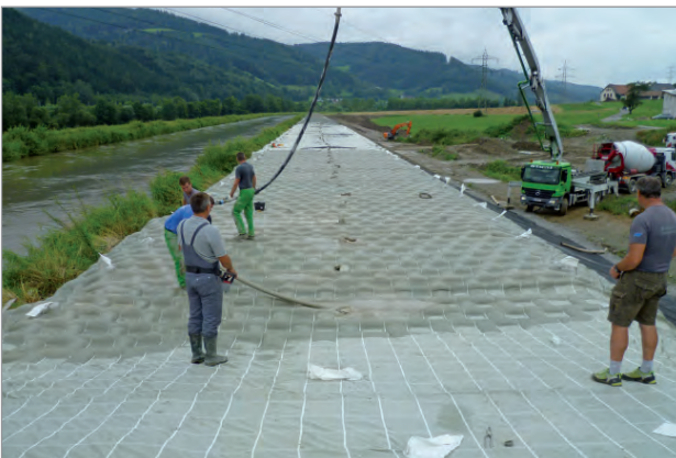
Befüllung mit Beton
