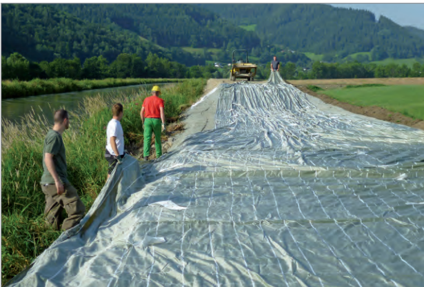
Verlegen des Incomat ®-Gewebes
