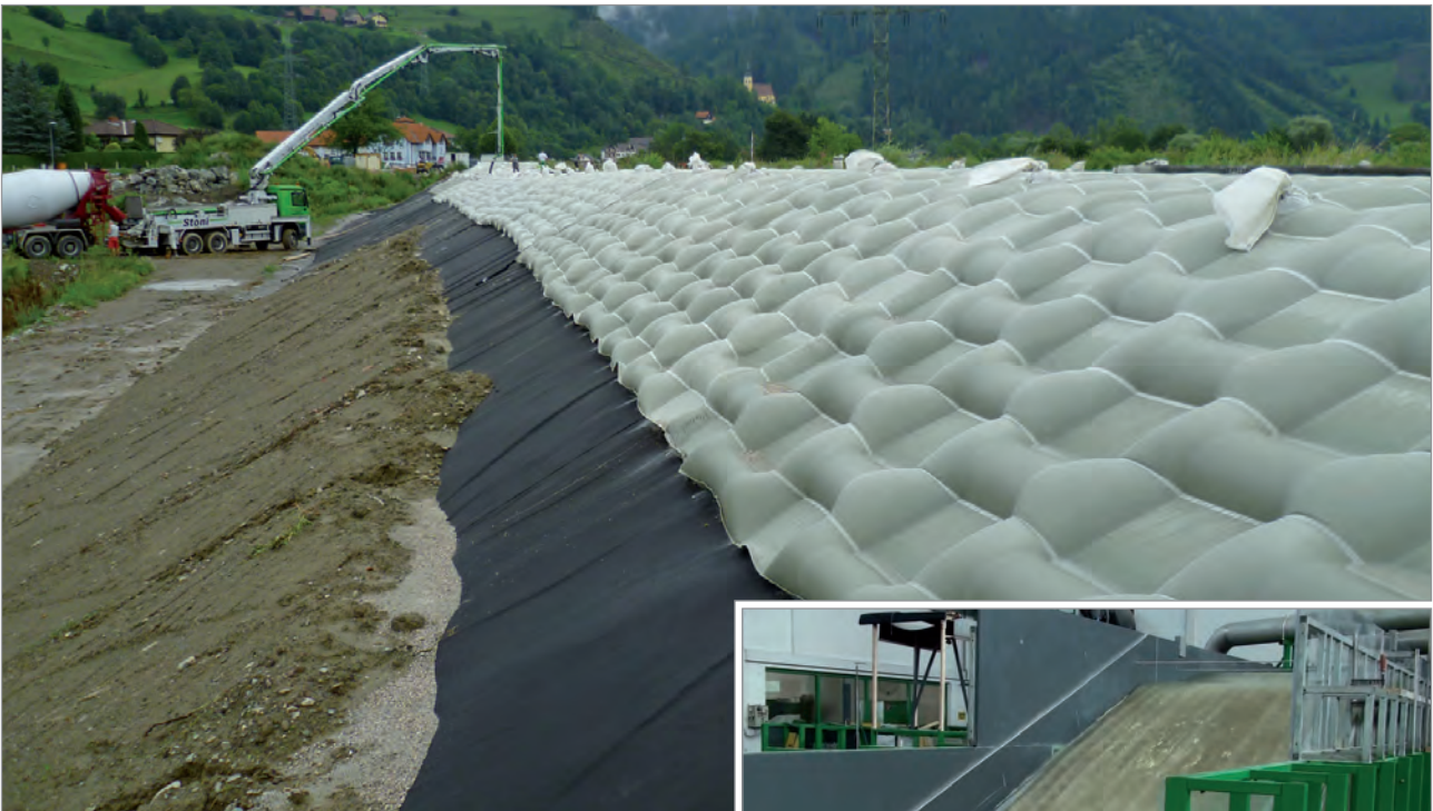
Incomat® Crib kurz nach der Befüllung mit Beton
