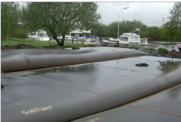
Entwässerungsfeld mit SoilTain® Entwässerungsschläuchen
