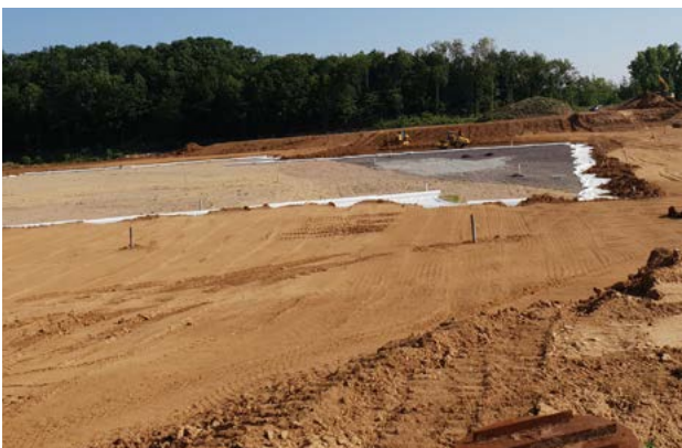
Einbau des Rekultivierungsbodens
