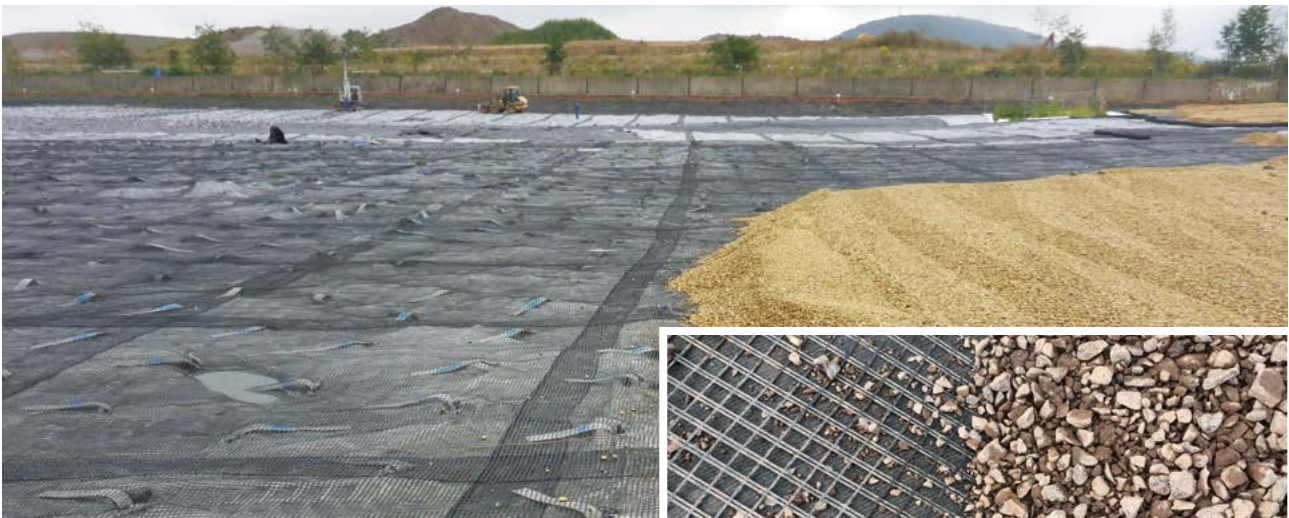
Einbau Dränschicht
