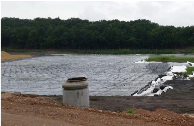
Verlegung der Filterlage und erste Bewehrungsebene
