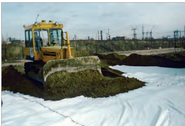
Einbau der Abdeckung auf Sand
