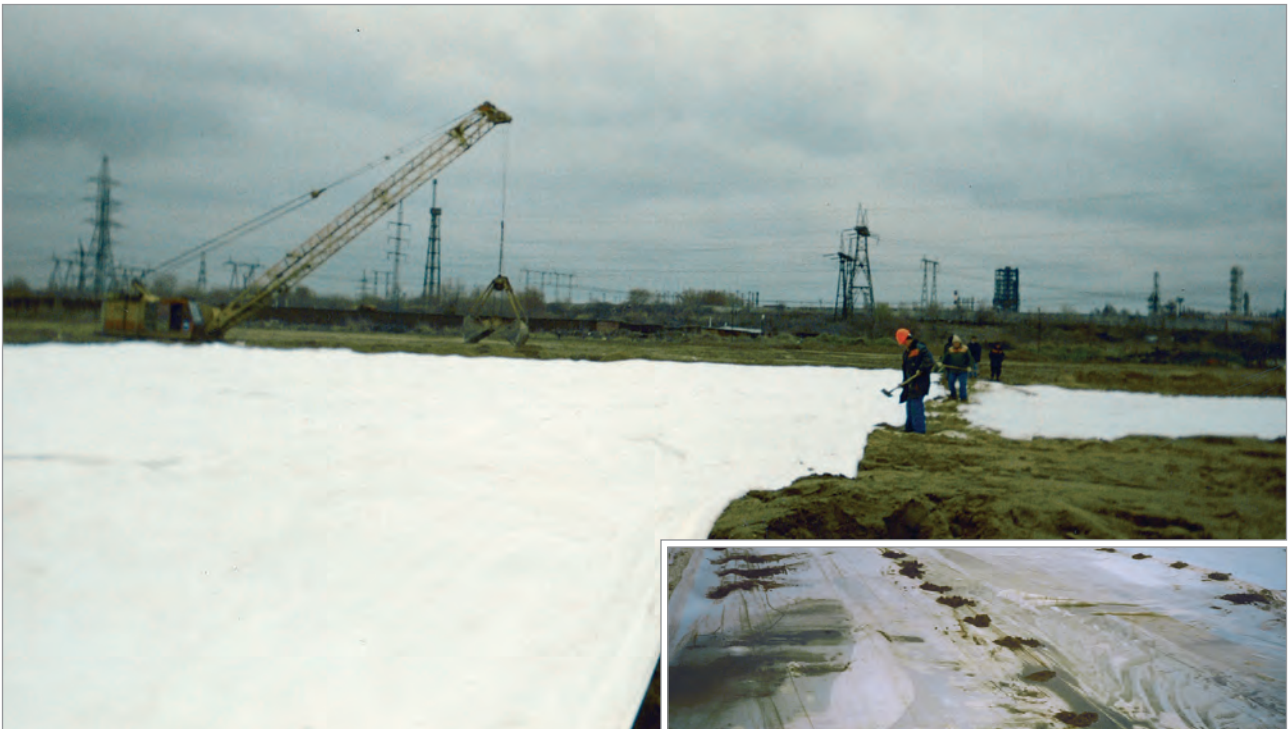
Verlegung der Stabilenka ® Panels
