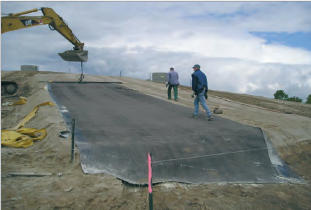
NaBento® wird auf der Ausgleichsschicht verlegt
