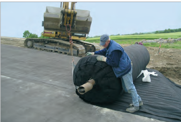
Auf die GTD wird Enkadrain® als dreischichtige Dränmatte aufgelegt
