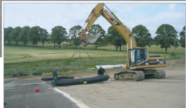
Die Verlegung der NaBento® Bahnen ist einfach und schnell
