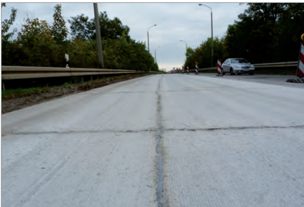
Gefräste und vorbereitete Unterlage
