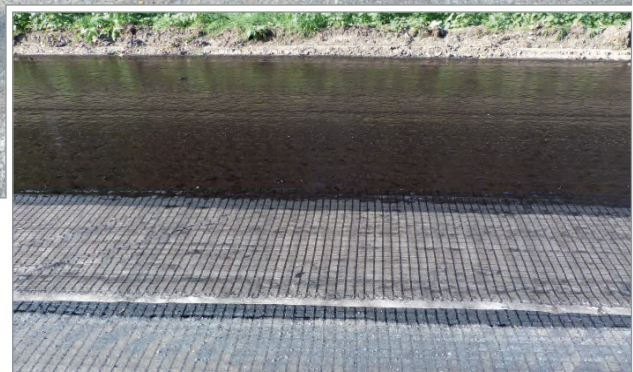
Ausschnitt: SamiGrid® verlegt
