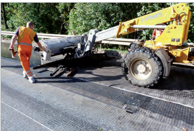
Verlegen von SamiGrid® in die Bitumenemulsion
