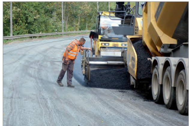
Einbau der Asphaltbinderschicht
