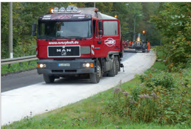
Aufbringen der Bitumenemulsion
