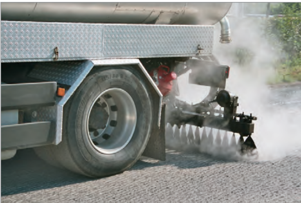
Bitumenemulsion wird angespritzt
