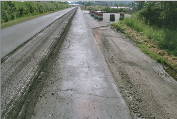
Nach dem Abfräsen der Deck- und Binderschicht
