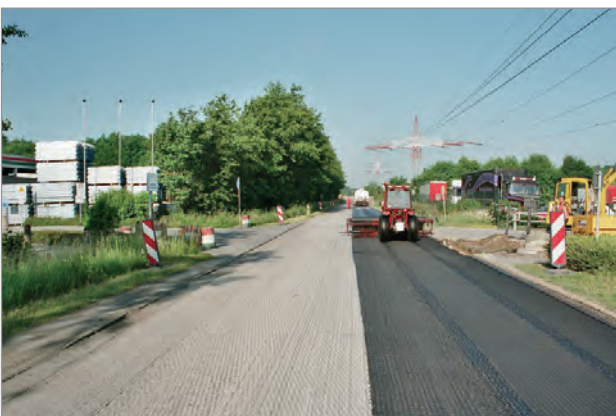
Verlegung des HaTelit® C 40/17
