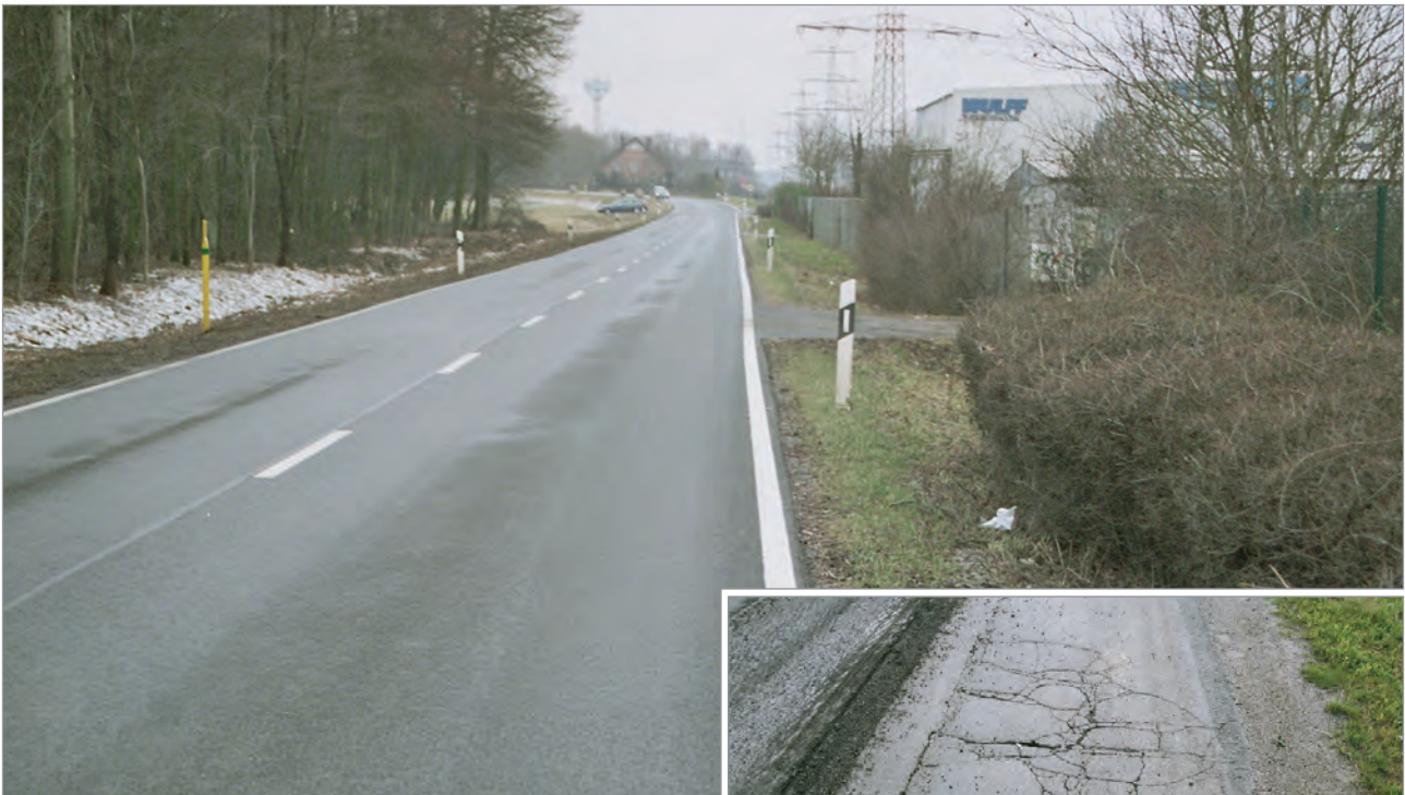
Zustand der neu sanierten K 81/Kreisgebiet Steinfurt
