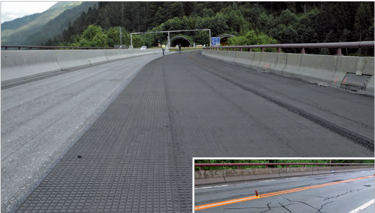
Die Arlberg Schnellstraße S 16 vor dem Westportal des Langener Tunnels.
