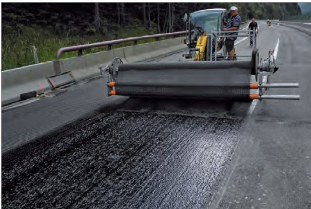
Verlegung von HaTelit® C 40/17 in die teilgebrochene Bitumenemulsion
