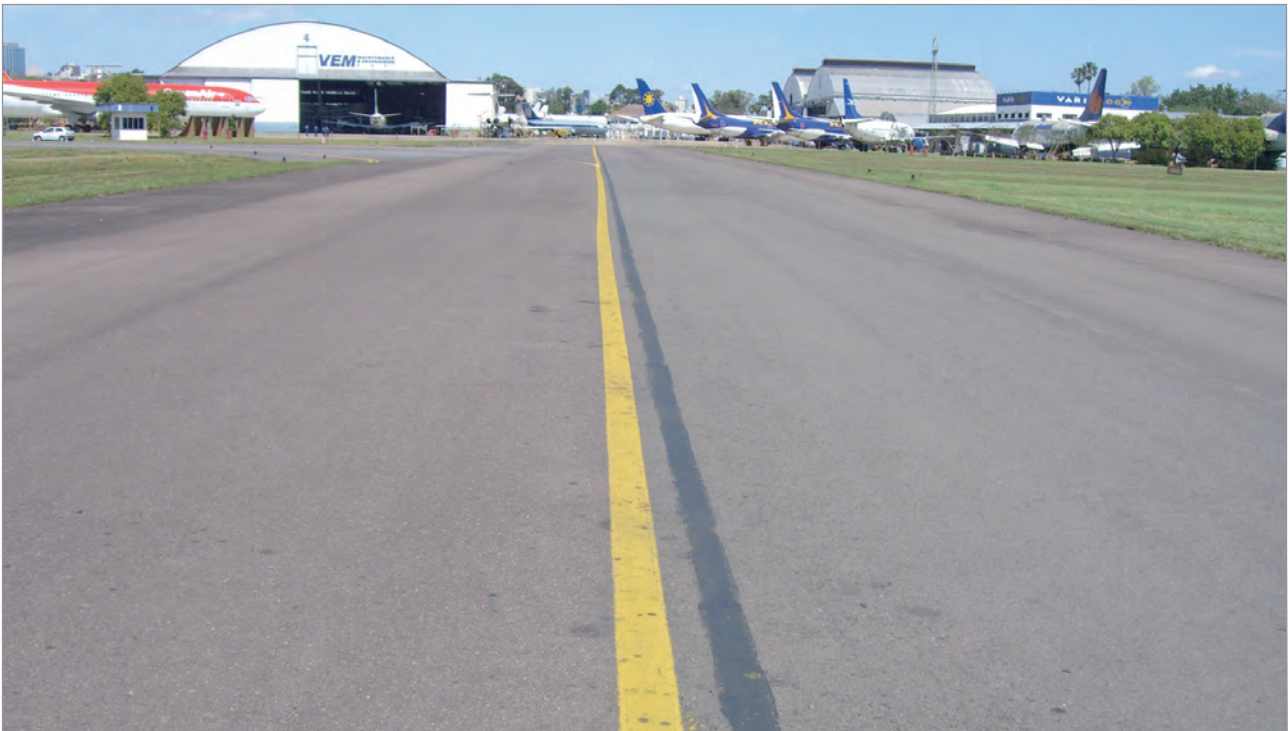
Beginn der Zufahrt zur Wartungshalle (2008)
