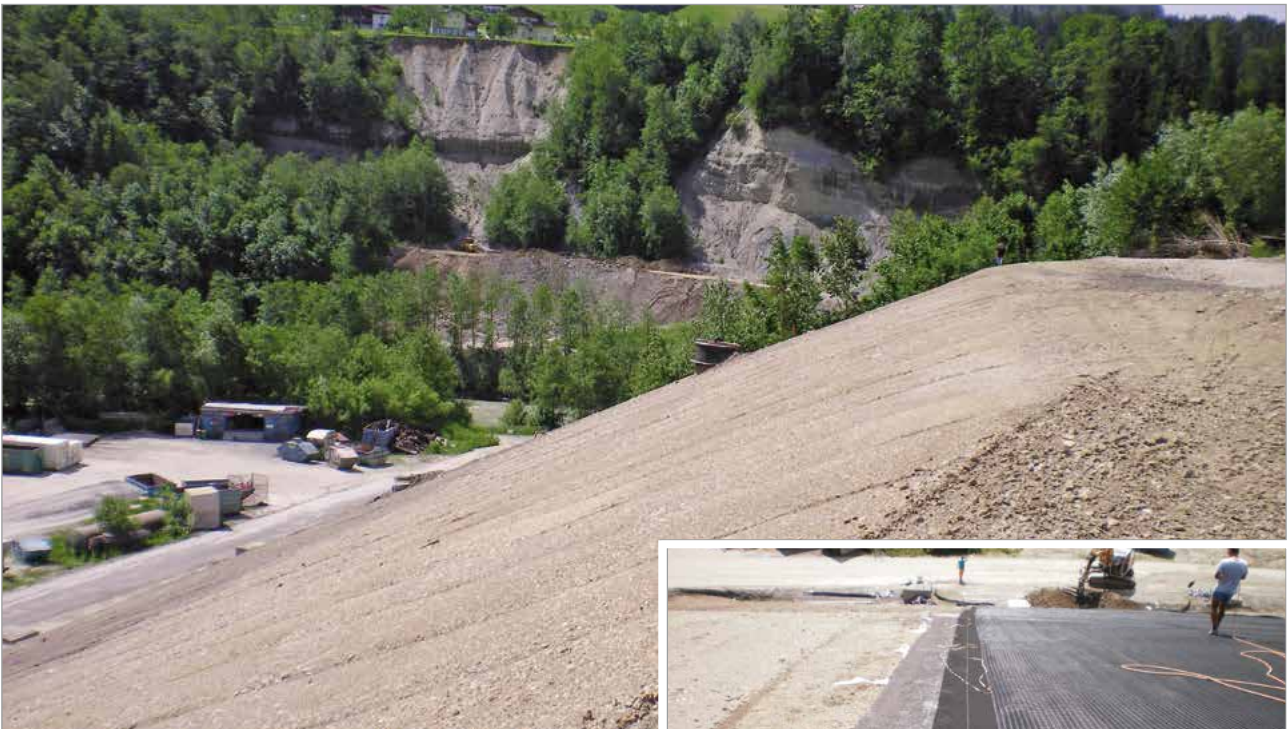
Oberflächenabdichtung nach Ende der Arbeiten
