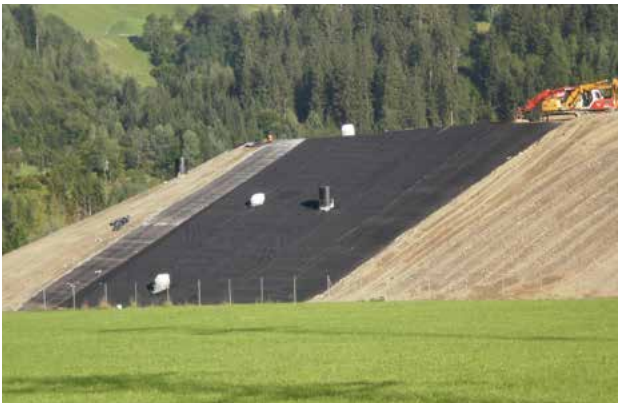
Verlegung der Drainagematte
