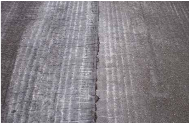
Schubfest verklebter Überlappungsstoß der GTD
