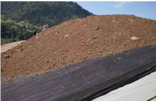
Schüttung des Abdeckbodens auf der Antigleitbewehrung
